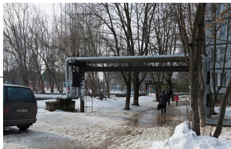
пешеходная тропа у рынка проходит под аркой теплотрассы
