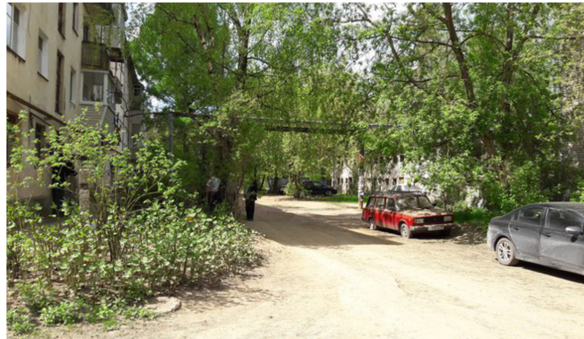
фото до реконструкции (04.05.16)
