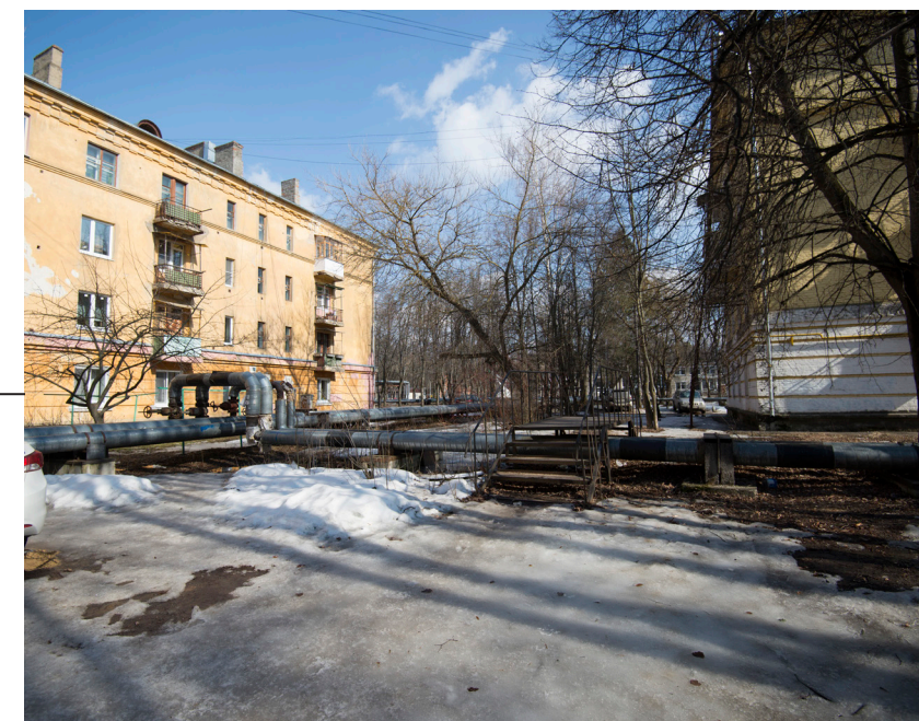
теплотрассы затрудняют проезд и проход ветхий жилой фонд
